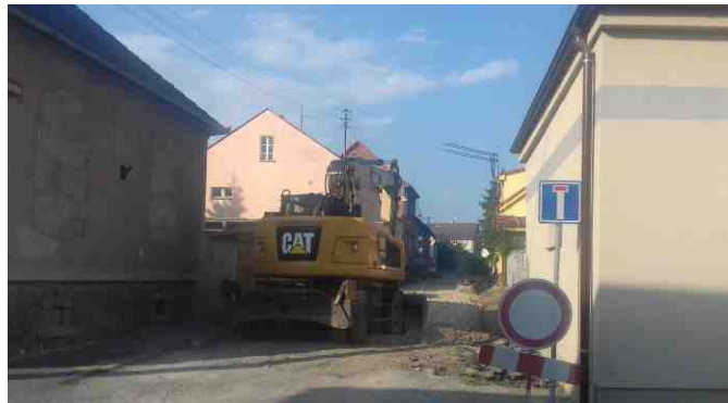
V ulici Palackého se již také začalo pracovat
