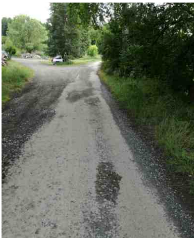
Opravě této komunikace na Janskou dalo zastupitelstvo zelenou
