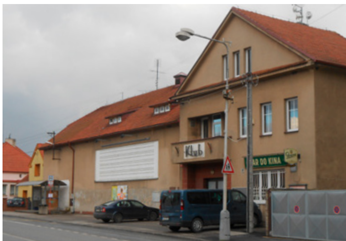
Zadávací dokumentace na zateplení KZ zatím schválena nebyla - foto JT
