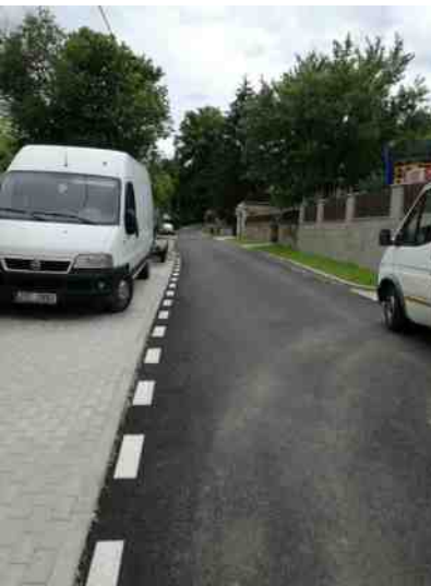
Ulice Tyršova po opravě
