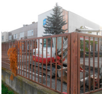
Parkoviště - stav prací na začátku července - foto JT
