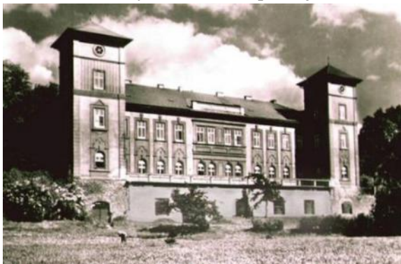
Historický snímek loděnického letohrádku, vřimně se rozsáhlých sklepních prostorů v suterénu budovy, hlavní vchod je skryt za keřem. Zdroj © Muzeum Českého krasu v Berouně
