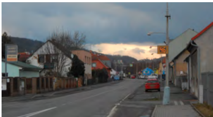
Oprava nezpevněného pruhu na Plzeňské se již řeší - foto JT
