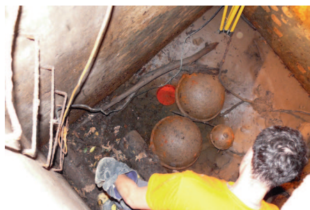
Pohled do dolní trkačové šachty ještě s nánosem bahna, kamení a větví. Šachta má půdorys 2,1 x 1,5 m a je hluboká asi 3,5 m. Stěny jsou vyzděny z cihel a skletovány cementovou maltou - po 120 letech existence nejeví šachta známky poškození
