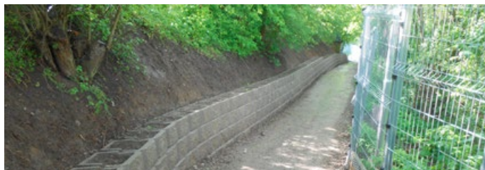
Nová opěrná zeď Na Skalce - foto JT
