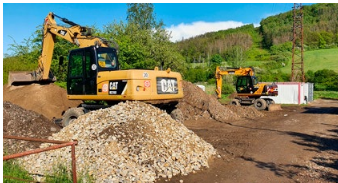
Stavební práce v Havířské ulici jsou v plném proudu - foto M.Bok
